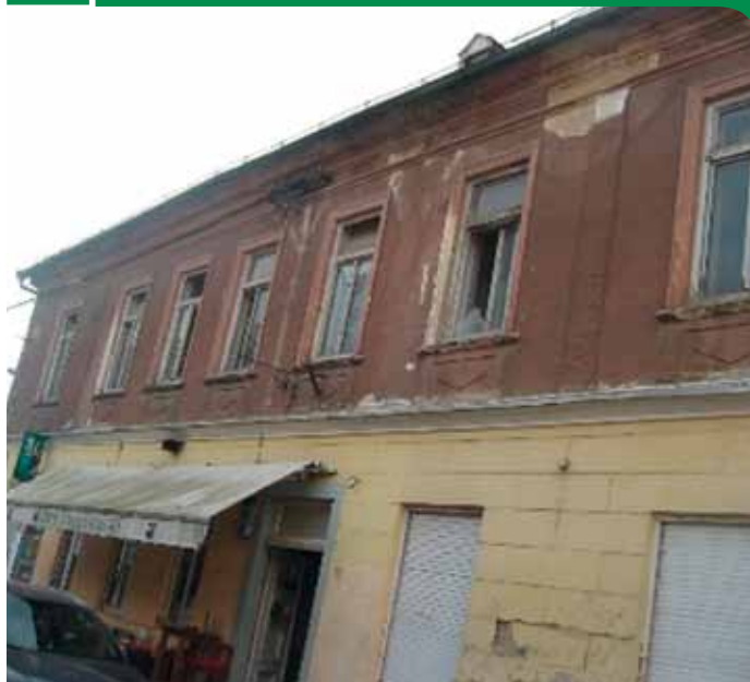
▲ Obstoječe stanje objekta Stari trg 11, sprednja stran, foto: Blaženka Čujež
